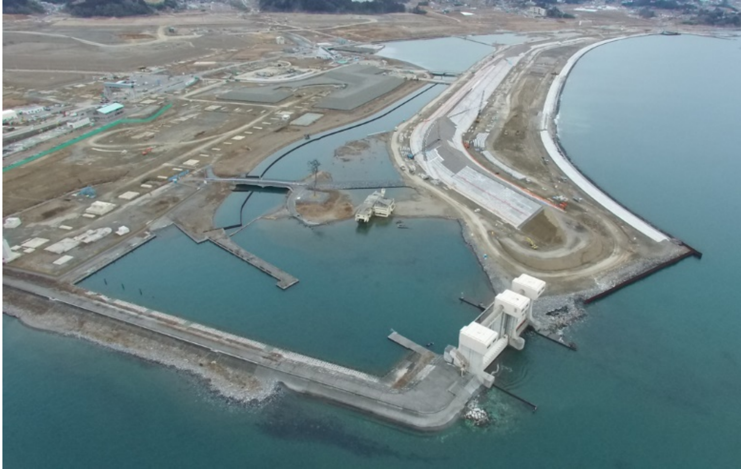
2016年の高田海岸の復興事業。 海岸域の水没地を埋め戻してTP3mの第1線堤と同12.5m第2線堤の2本の防潮堤、第2線堤から連続した河口防潮水門などの建設が進行中。
